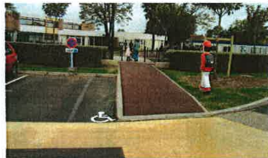
Accès à l'école du Coudray-Montceaux
