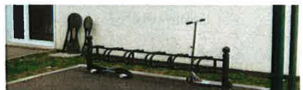
Type de stationnement non préconisé : pas de bonne protection contre le vol (attache iniquement par la roue avant) et risque de voiler la roue.
