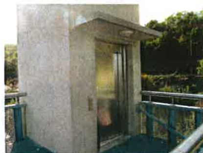
Passerelle sur l'écluse - Le Coudray Montceaux
