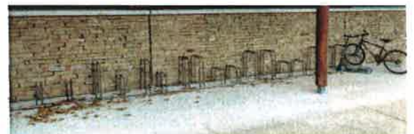
Type de stationnement non préconisé : pas de bonne protection contre le vol (attache iniquement par la roue avant) et risque de voiler la roue.
